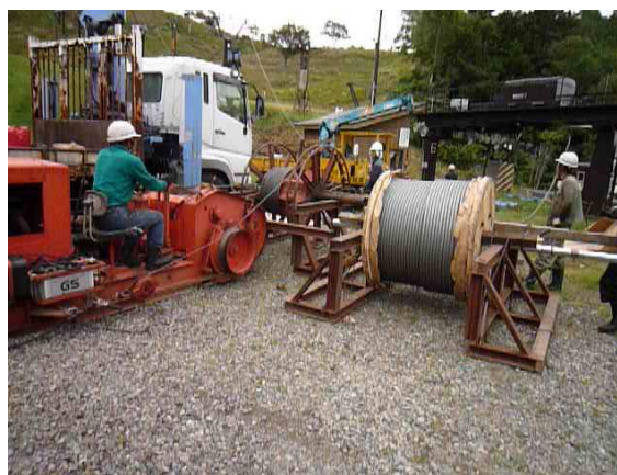
第1ペアリフト鋼索交換作業状況
