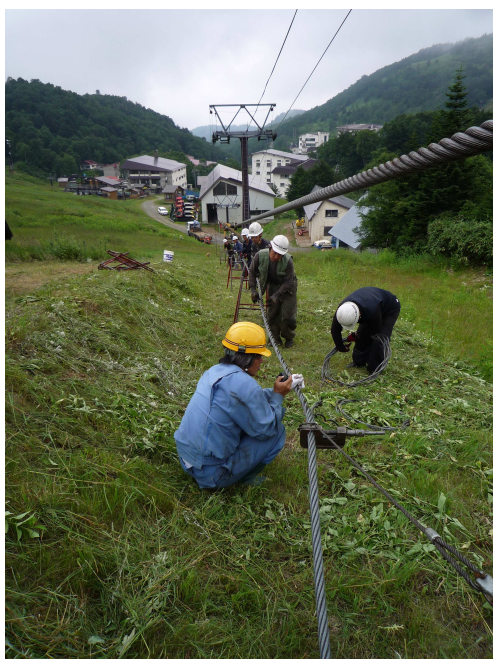
第3クワッドリフト鋼索切詰作業状況
