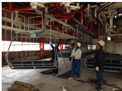
第3クワッド受装置分解点検状況
